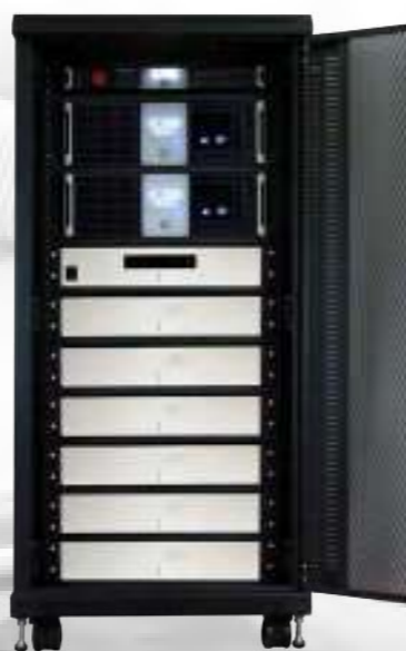
エネルギーマネジメント システム
