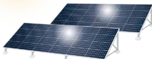
メガソーラー発電所
